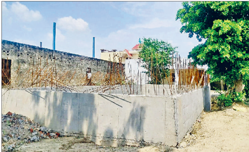
उचाना। अंडरपास के पास चल रहा बूस्टिंग स्टेशन का निर्माण कार्य।
